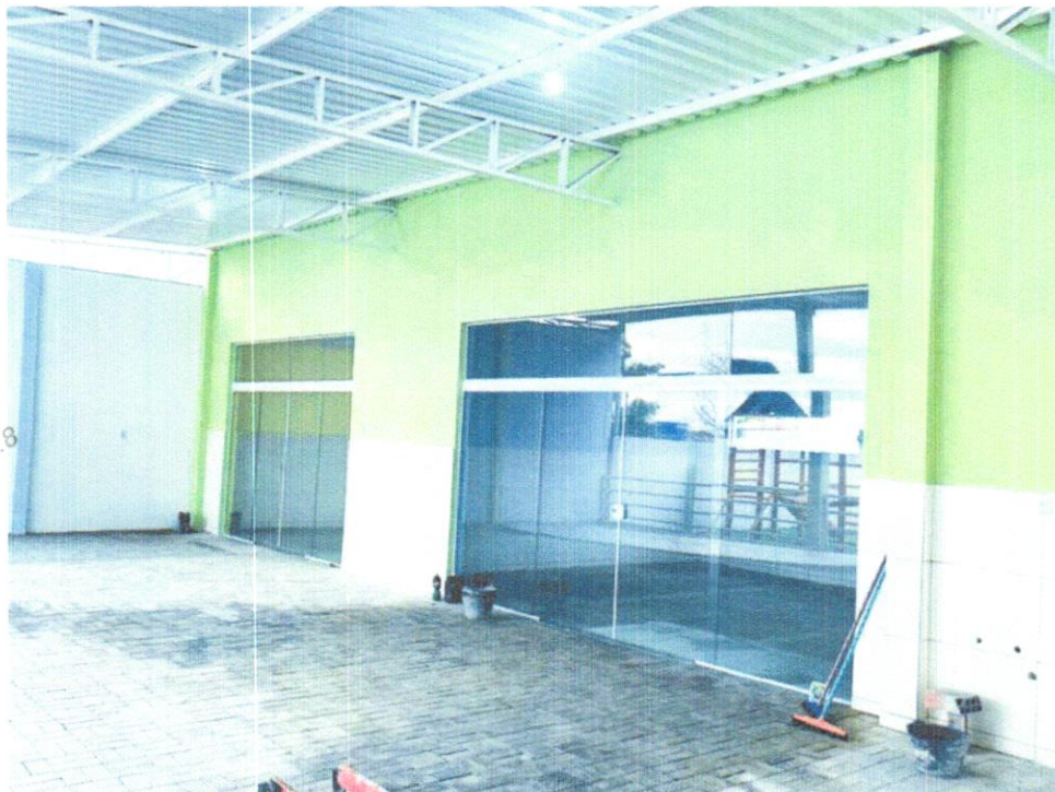
FOTO 16 – TELHAMENTO COM TELHA METÁLICA TERMOACÚSTICA
