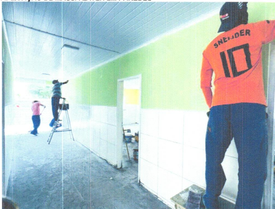
FOTO 31 – APLICAÇÃO DE MASSA LÁTEX EM PAREDES
