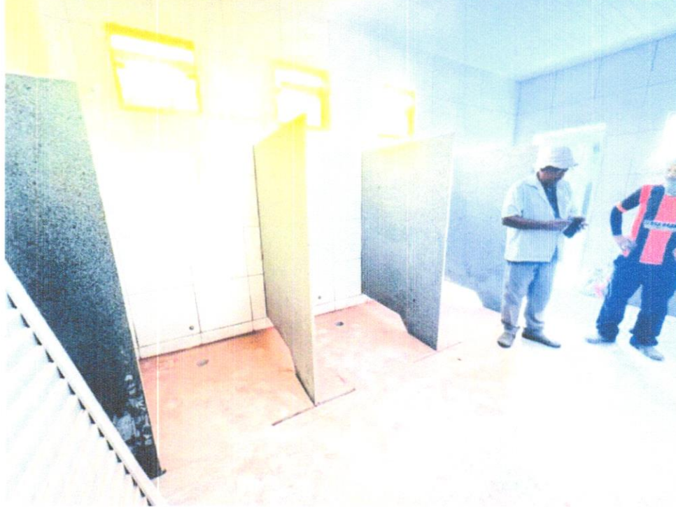
FOTO 34– INSTALAÇÃO DE DIVISÓRIAS EM GRANITO CINZA PARA MICTÓRIOS PÓLIDOS
