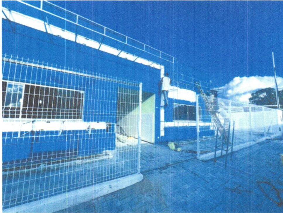
FOTO 16 – TELHAMENTO COM TELHA METÁLICA TERMOACÚSTICA
