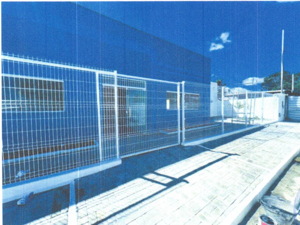
FOTO 14 – INSTALAÇÃO PORTÃO PARA GRADIL DO TIPO MORLAN
