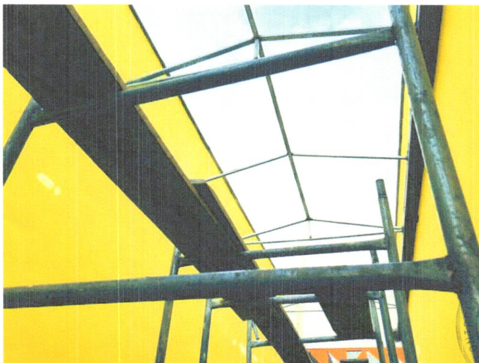
FOTO 20 – INSTALAÇÃO DE CHAPAS DE POLICARBONATO
