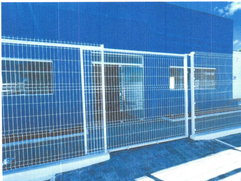
FOTO 12 – INSTALAÇÃO GRADIL TIPO MORLAN
