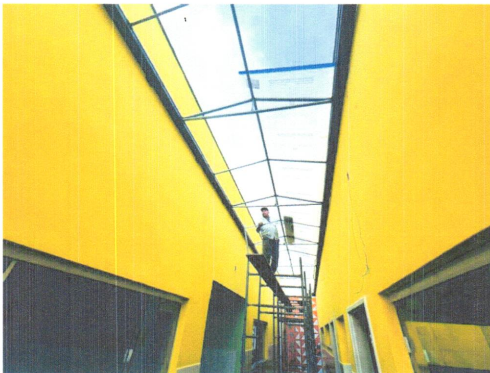
FOTO 20 – INSTALAÇÃO DE CHAPAS DE POLICARBONATO
