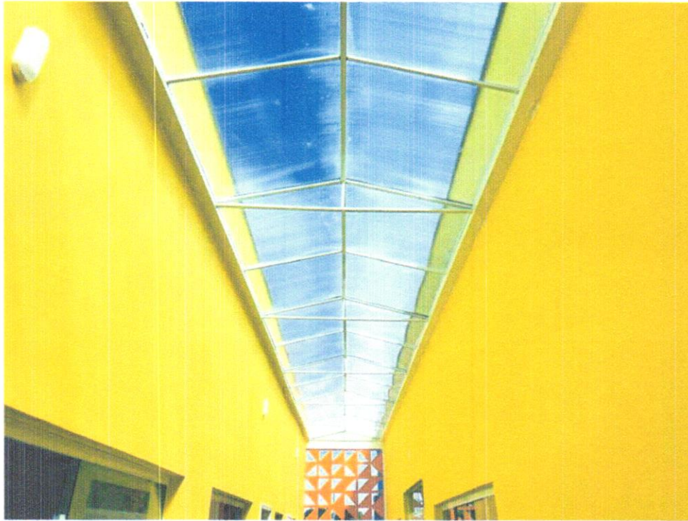
FOTO 22- INSTALAÇÃO DE CHAPAS DE POLICARBONATO
