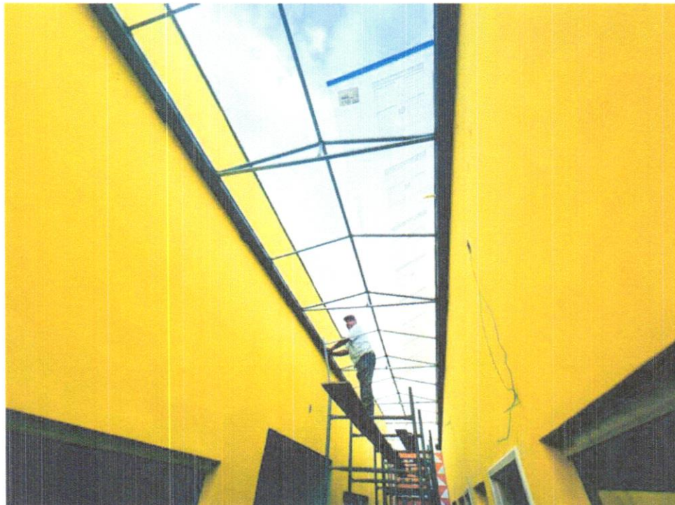
FOTO 18 – INSTALAÇÃO DE CHAPAS DE POLICARBONATO
