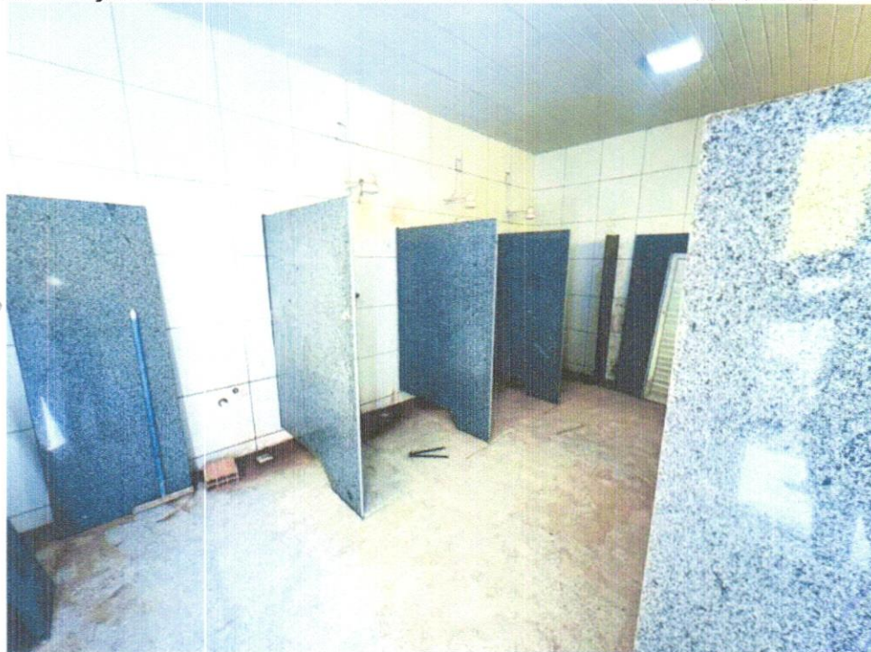
FOTO 34– INSTALAÇÃO DE DIVISÓRIAS EM GRANITO CINZA PARA MICTÓRIOS PÓLIDOS
