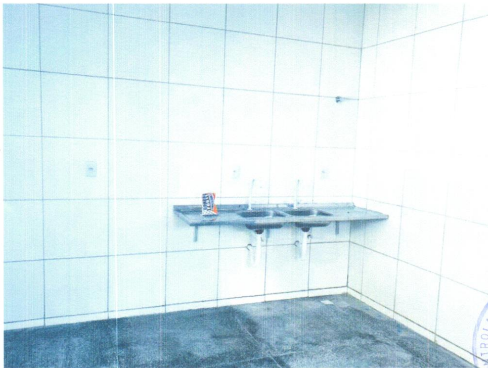
FOTO 40 – INSTALAÇÃO DE LAVATÓRIO COM BANCADA EM GRANITO CINZA ANDORINHA COM 02 CUBAS DE EMBUTIR DE LOUÇA, SIFÃO CROMADO, VÁLVULA CROMADA E TORNEIRA CROMADA.
