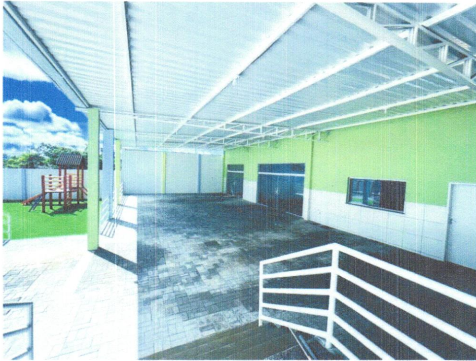
FOTO 18 – INSTALAÇÃO DE CHAPAS DE POLICARBONATO
