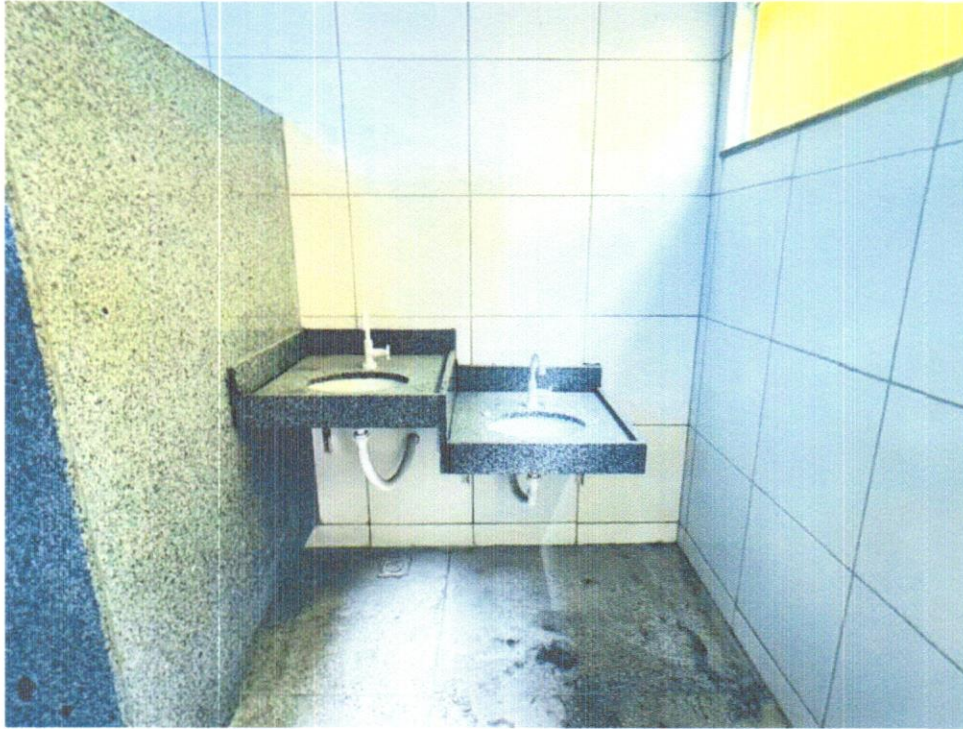
FOTO 42 – INSTALAÇÃO DE LAVATÓRIO COM BANCADA EM GRANITO CINZA ANDORINHA COM DUAS CUBAS DE EMBUTIR DE LOUÇA, SIFÃO CROMADO, VÁLVULA CROMADA E TORNEIRA CROMADA.
