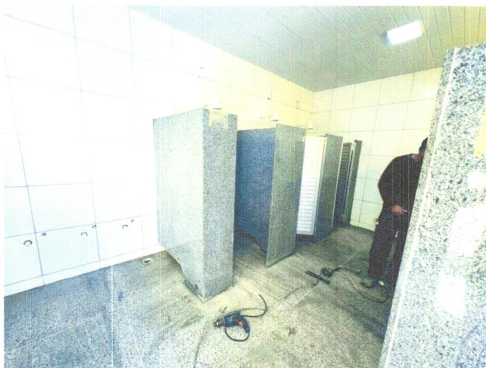
FOTO 32 – INSTALAÇÃO DE DIVISÓRIAS EM GRANITO CINZA PARA MICTÓRIOS PÓLDOS
