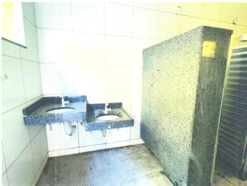
FOTO 42 – INSTALAÇÃO DE LAVATÓRIO COM BANCADA EM GRANITO CINZA ANDORINHA COM DUAS CUBAS DE EMBUTIR DE LOUÇA, SIFÃO CROMADO, VÁLVULA CROMADA E TORNEIRA CROMADA.
