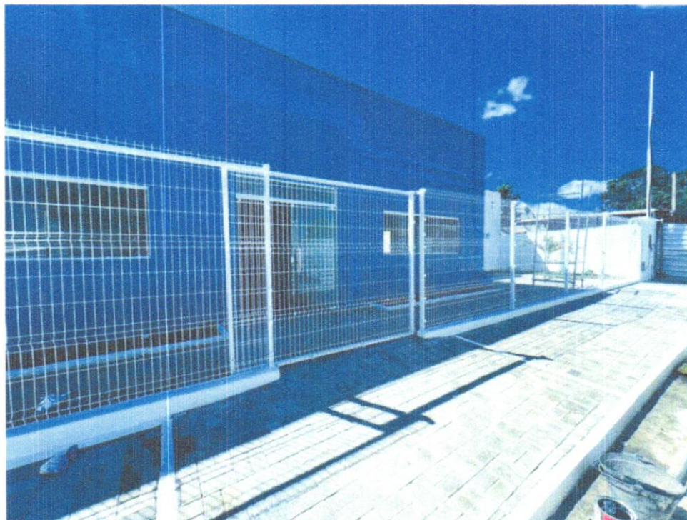
FOTO 12 – INSTALAÇÃO GRADIL TIPO MORLAN
